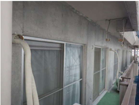
写真 2.4 補強部写真（補強前）ベランダ
