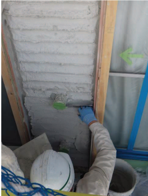
ポリマーセメントモルタルの塗り込め
