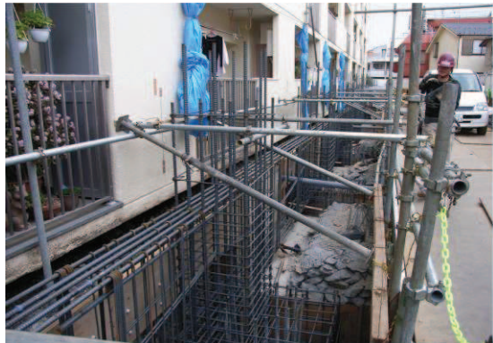
写真 1.4 外付けフレーム下部配筋状況
