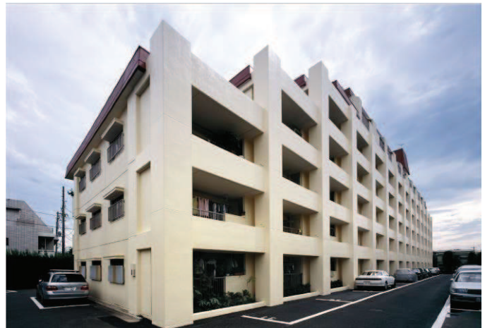
写真 1.2 建物外観写真（改修後）
