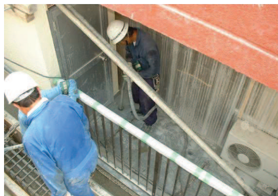
写真 1.6 増設スラブコンクリート打設
