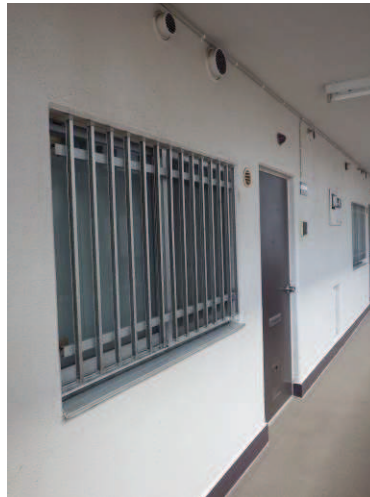
写真 2.2 補強部写真 （補強前）内廊下
