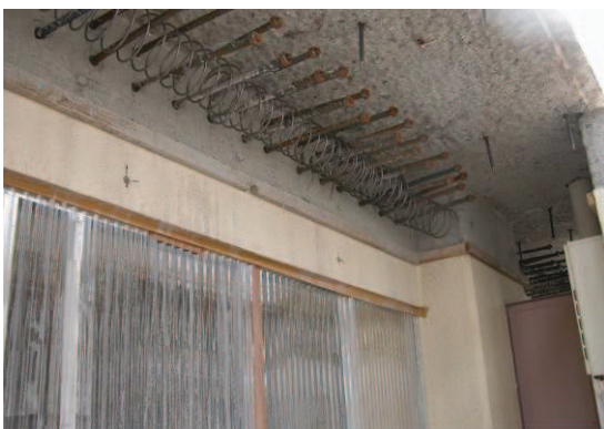
写真 1.5 サッシュ養生とバルコニー下施工状況
