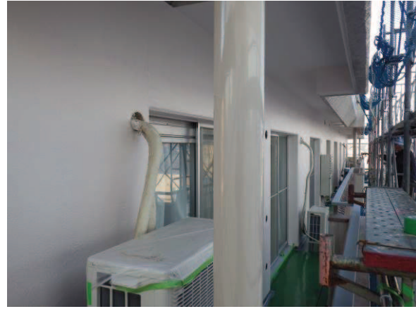
写真 2.5 補強部写真（補強後）ベランダ
