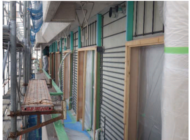
鉄筋取付状況
