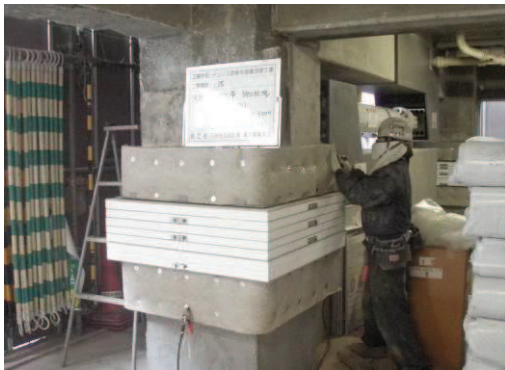
免震装置への耐火被覆の設置
