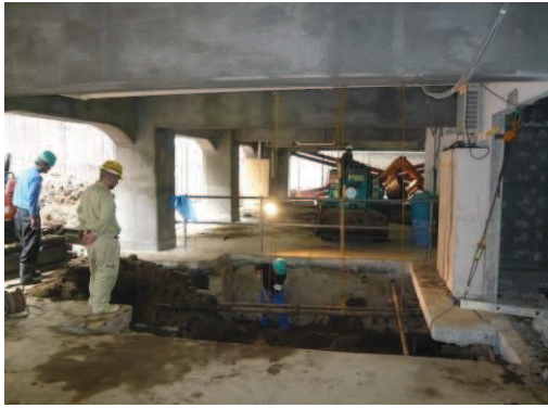
基礎梁補強のための掘削状況
